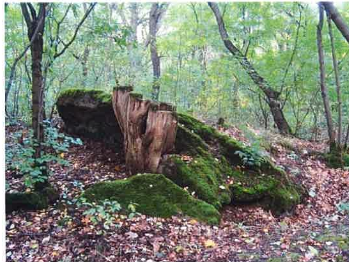
Fot. 3. Fragment żelbetowego płaszcza schronu (1d), widok z południowego zachodu. Widoczne odspajanie się dolnej i górnej warstwy.
