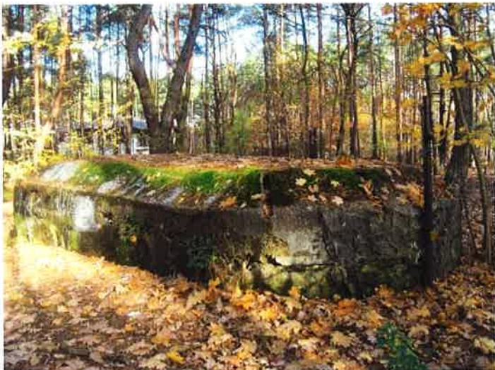
Fot. 14. Schron obserwacyjny (2a) - widok z południowego zachodu na ścianę prawą i czołową z zachowanym tynkiem maskującym i poziomym rowkiem po listwie do jego mocowania, w skosie nad ścianą czołową rowki pionowe. Szczelina obserwacyjna pod obecnym poziomem terenu.
