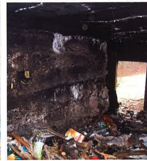
Fot. 30. Wnętrze schronu (3a) - po lewej prawa ściana izby obserwatora z odcisniętymi belkami i otworem instalacyjnym, w głębi przedsiionek z otworem wejściowym.
