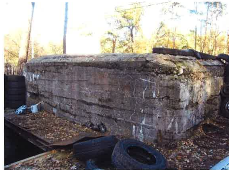
Fot. 44. Schron bojowy (4d) - widok z południowego wschodu na ścianę prawą z wejściem do przelotni, dostępnym przez zejście do współczesnego kanału rewizyjnego (schodki poza kadrem) i ścianę czołową zasypaną do poziomu dolnej krawędzi strzelnicy ckm.
