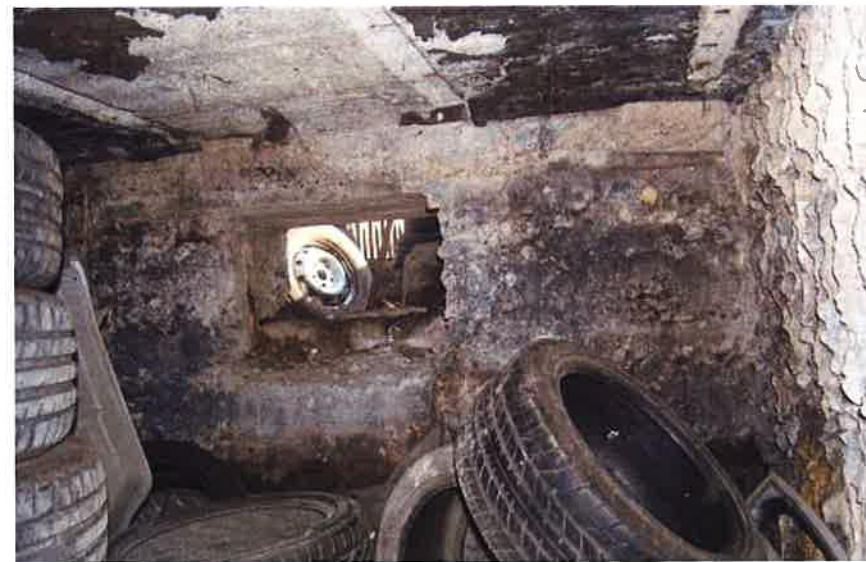
Fot. 47. Schron (4d) - wnętrze izby bojowej. W ścianie czołowej strzelnica ckm wewnątrz z zabetonowanymi w policzkach drewnianymi klockami i zagłębieniem poniżej na dostawiany do ściany drewniany podest. W ścianie prawej ślady po zerwanych arkuszach blachy falistej, w stropie wzdłużne bruzdy i resztki wtórnie naklejonej papy.
