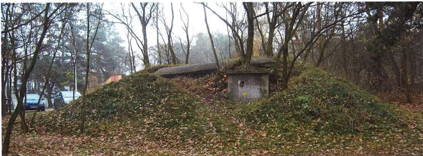
Fot. 37. Schron bojowy (3d) - widok ogólny z kierunku północnego, na lewą ścianę. Na pierwszym planie teren współcześnie splantowany poniżej poziomu wejścia do schronu. Nasyp przekształcony podczas adaptacji przez Obronę Cywilną zasłonił cały schron poza dostawionym do północnego wejścia przelotni prefabrykowanym przedsiönkiem, osunięcie ziemi odsłoniło krawędź lewej ściany i stropu oraz zakryło w 1/3 zamurowane wejście. Widoczne wyjątkowo duże nachylenie stropu do przodu.
