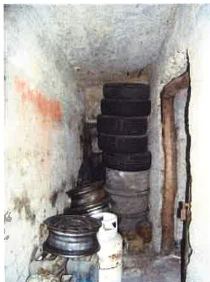
Fot. 46. Schron (4d) - wnętrze przelotni ze skośnym stropem. Na wprost zamurwane wejście wschodnie z elementami drewnianej ościeżnicy, z prawej wejście do izby bojowej z widocznym węgarciem.
