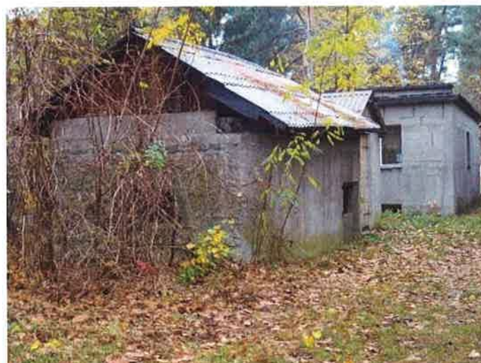
Fot. 18. Schron bojowy (2c), zaadaptowany na cele gospodarcze i rozbudowany - widok z południowego wschodu na ścianę czołową z otworem strzelniczym ckm (po lewej) i prawą z częściowo zamurowanym wejściem do przelotni, górne krawędzie ścian nadmurowane współcześnie.
