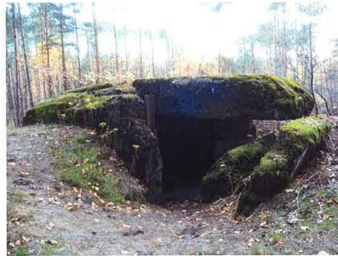
Fot. 10. Schron (1g) - widok z północy, z rowu dobiegowego na lewą ścianę, wejście do przelotni i odchyloną wybuchem tylną ścianę, o którą opiera się oderwany fragment stropu z nad lewej części przelotni i narożnika izby bojowej. Widoczny brak zniszczonej wybuchem lewej części ściany działowej, na jej prawej części krawędź otworu wejściowego z węgarkiem.
