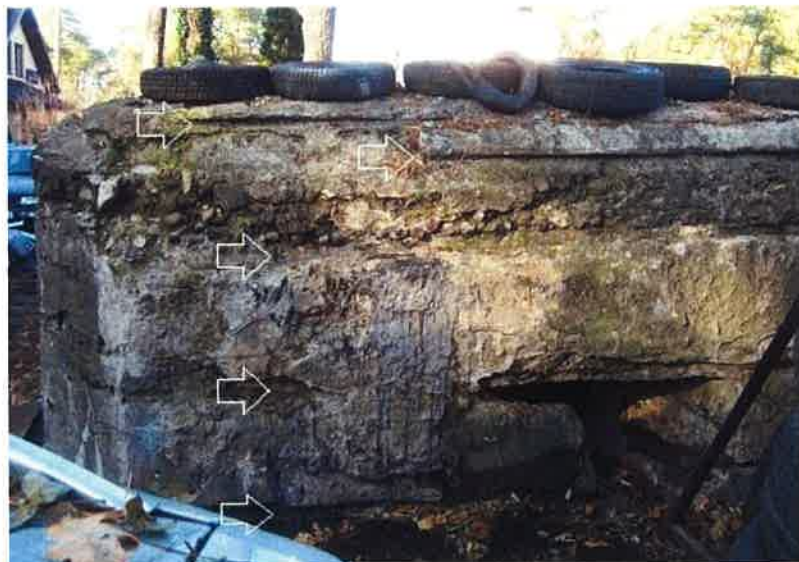
Fot. 45. Schron (4d) - widok ściany czołowej ze strzelnicą ckm z resztkami rozkutego zamurowania i odsłoniętym lewym policzkiem. Wokół strzelnicy zachował się tynk maskujący, strzałki wskazują rowki o trapezowym przekroju po drewnianych listwach do jego mocowania.
