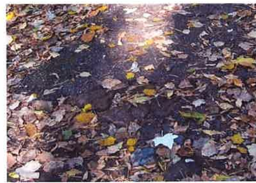
Fot. 50. Bruk na drodze (5b), przykryty cienką warstwą złączającego się asfaltu.
