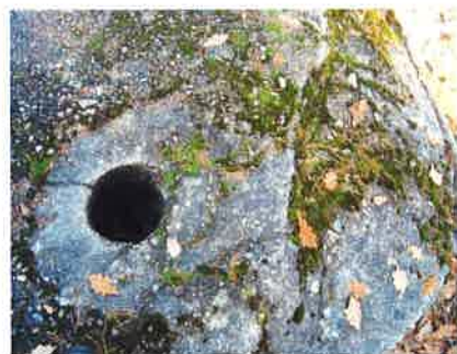
Fot. 27. Schron (3a) - otwór dla peryskopu i/lub rakietnicy, nachylny w kierunku ściany czołowej (krawędź widoczna po prawej).
