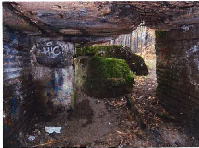
Fot. 12. Wnętrze schronu (1g) - widok z izby bojowej na zachowaną prawą część ściany działowej (po lewej stronie kadru) z bocznią krawędzią i nadprożem otworu wejściowego, za nią leżący wewnątrz przelotni fragmentem stropu (pochodzącym z wyrwy, widocznej po prawej stronie u góry) i ścianę tylną przelotni.
