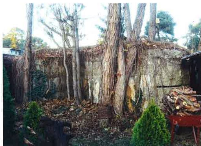
Fot. 23. Schron obserwacyjny (2f) - widok z południowego zachodu na ścianę prawą z aneksem przedsionka i wieloboczną ścianą czołową ze szczeliną obserwacyjną i zachowanym tynkiem maskującym.
