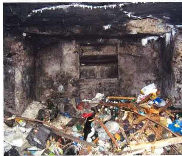
Fot. 29. Wnętrze schronu (3a) - okopcone i zasypane śmieciami, widok na wnąkę z otworem obserwacyjnym w ścianie czołowej. Okładzina stropu wtórna.
