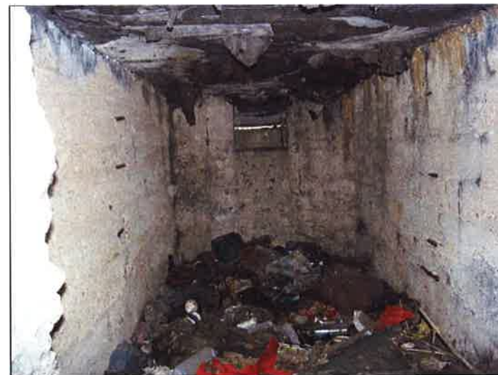
Fot. 41. Schron (3f) - wnętrze „wąskiej” izby obserwatora (170 cm) w widoku z przelotni, częściowo zasypane śmieciami. W ścianie czołowej otwór obserwacyjny z wnęką, na bocznych widoczne fragmenty zbrojenia. Strop oklejony wtórnie papą, zastępującą pierwotne otwory.
