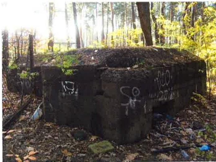
Fot. 15. Schron (2a) - widok z północnego wschodu na ścianę tylną z zasypanym w większości wejściem i lewy bok schronu z dochodzącym do lica ściany przedsionka dwuteownikiem, wzmacniającym jego strop. Schron położony na terenie dwóch działek - widać ogrodzenie, za którym znajduje się jego narożnik.
