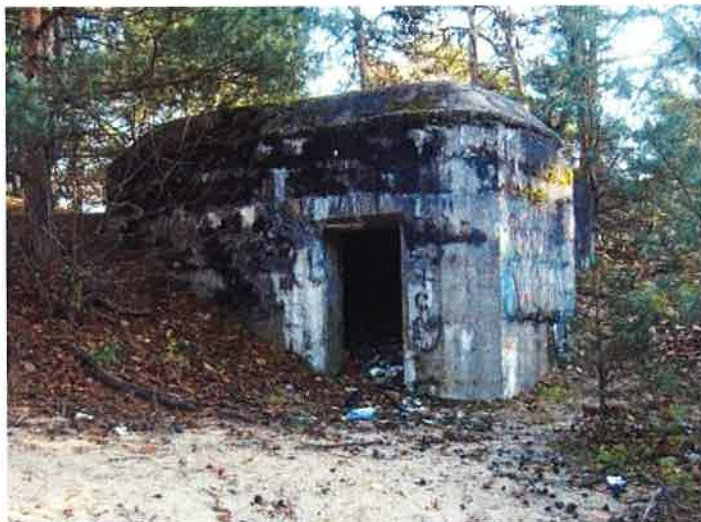
Fot. 24. Schron obserwacyjny (3a) - widok z północnego zachodu na ścianę tylną z wejściem i prawą z aneksem, odsłoniętą po osypaniu się ziemi do wyrobiska. Ślady smolowania prawdopodobnie pochodzą z okresu użytkowania przez Obronę Cywilną po 2. wojnie światowej.
