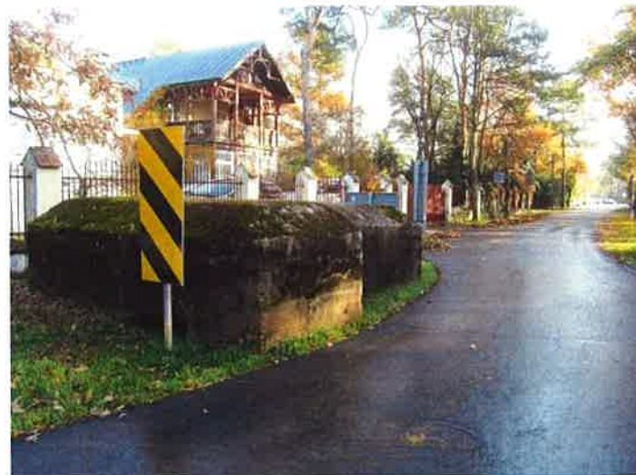
Fot. 16. Schron obserwacyjny (2b) - widok z północnego zachodu na tylną ścianę z zasypanym wejściem i prawy bok z aneksem przedsionka.
