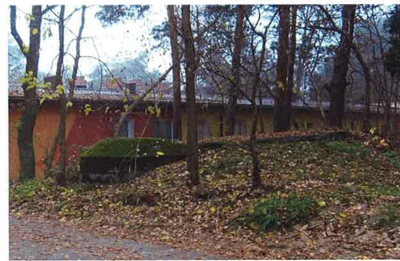
Fot. 33. Stanowisko obserwacyjne (3c) - widok ze wschodu na ścianę czołową i lewą. Widoczny grubszy strop przy ścianie czołowej, jego obniżenie i następnie łagodne wznoszenie do tylnej krawędzi obiektu. Kształt nasypu wtórny, przykrywa pozostałości rozebranych części budowli.
