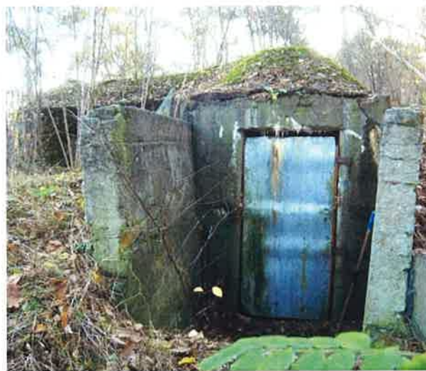
Fot. 32. Schron (3b) - widok na północne wejście do przelotni z wtórnymi murami oporowymi i drzwiami.
