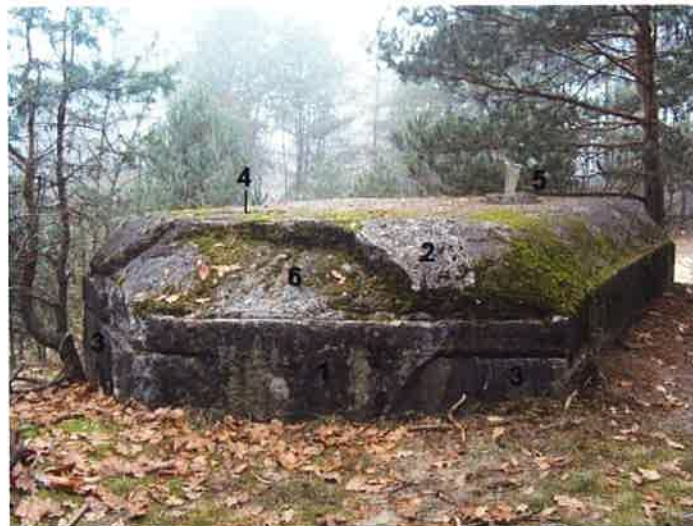
Fot. 25. Schron (3a) - widok z południowego wschodu na ścianę czołową i lewą. 1,2 - tynk maskujący na ścianie czołowej i skosie stropu z granicą tynkowania, 3 - rowki po drewnianych listwach, 4 - otwór peryskopu/rakietnicy, 5 - otwór dymowy, 6 - miejsce zniszczenia warstwy wierzchniej. Szczelina obserwacyjna zasypana.
