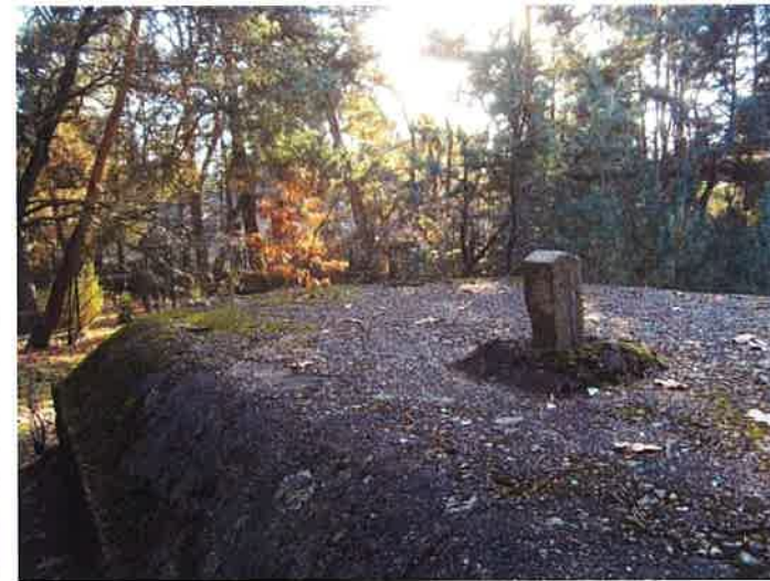
Fot. 26. Schron (3a) - wykończenie krawędzi stropu i otworu dymowego (z wrzuconym słupkiem z ogrodzenia), w głębi przy krawędzi skosu nad ścianą czołową otwór dla peryskopu.
